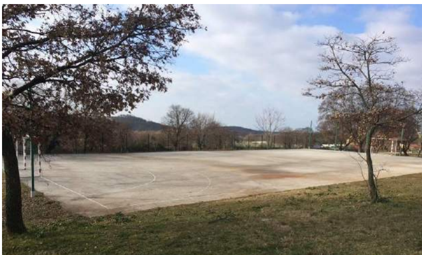
Slika 14. Postojeće sportsko igralište u naselju Golaš
